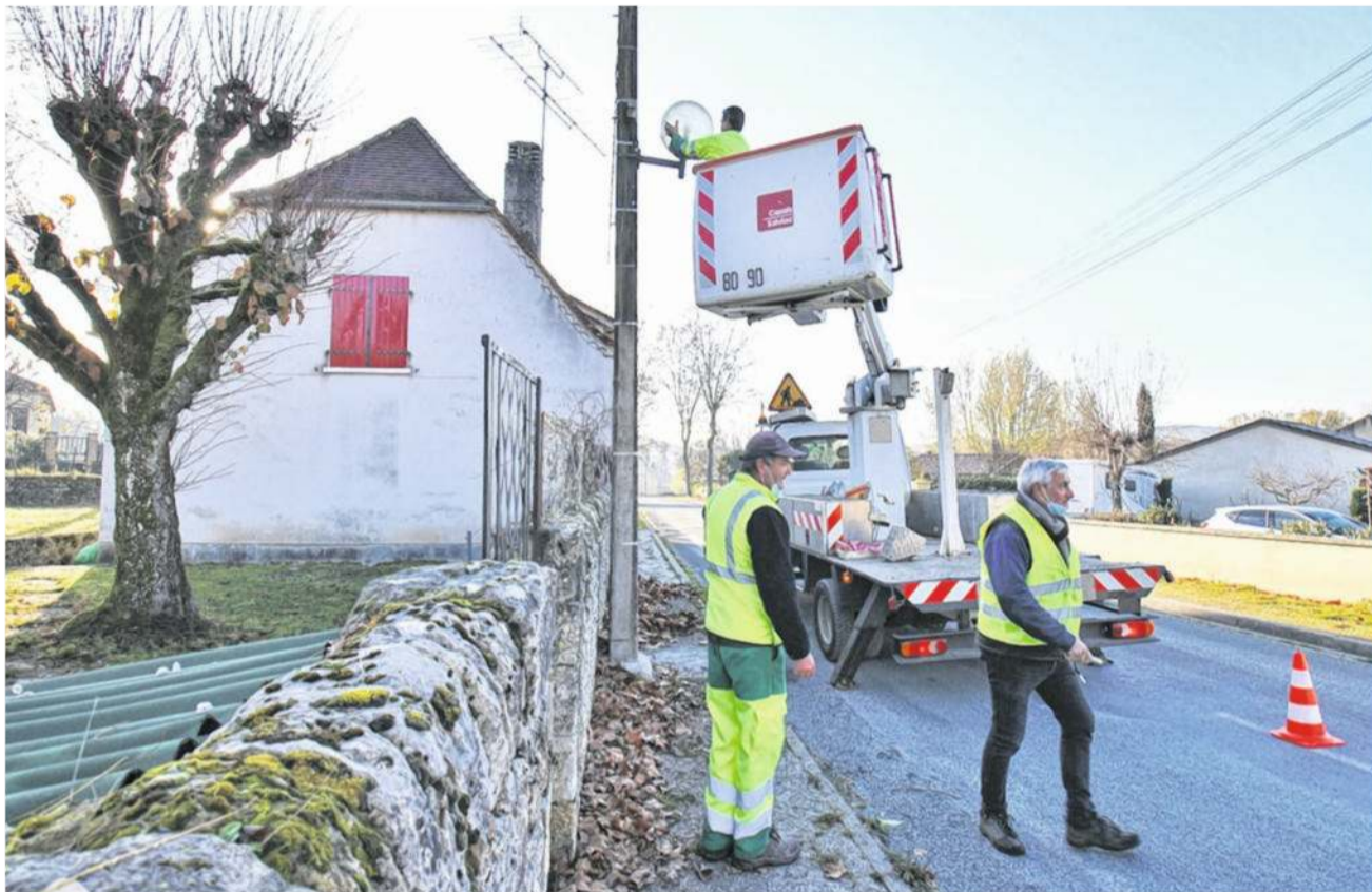
Automne 2020 : Les employés municipaux procèdent au nettoyage des globes de l'éclairage public sous la supervision de Francis Raclot en utilisant la nacelle de la Communauté de communes. © Luc Gétreau
